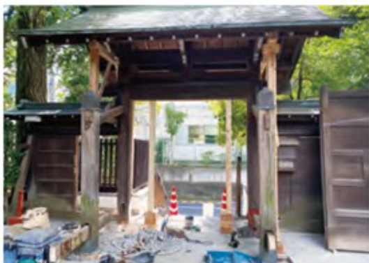
裏門の改修。環七時代より使われている大切な門です。
